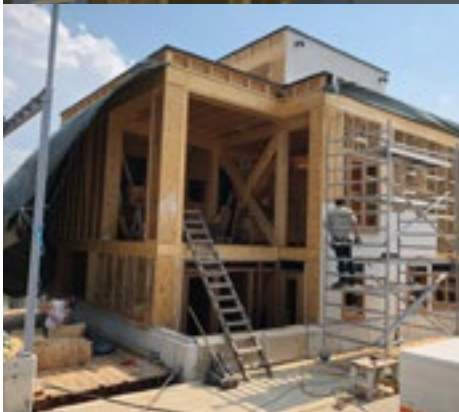
Drijvende strowoning (2018–2019) Stro gebruikt voor: wanden
